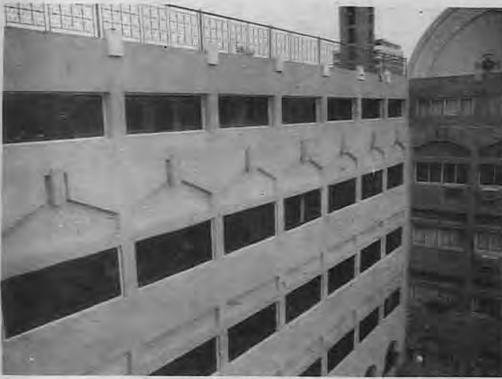
مبنى إسقفية الخدمات
